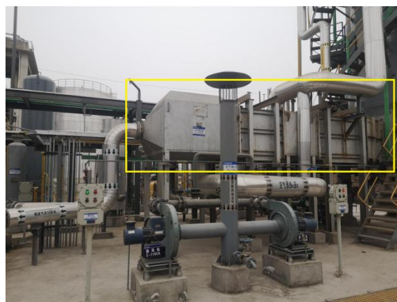
图 3-6 制氢装置空气预热器
