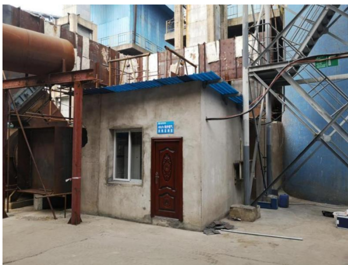
图 4-4 45t/h 锅炉废气在线监测室
