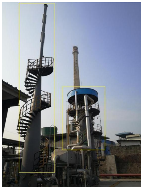
图 3-3 制氢装置排气筒和转化炉
