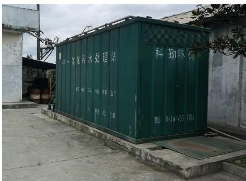
图 3-5 一体化生活污水处理装置
